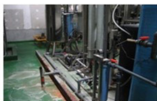
鍋爐房RO製程廢水回收 每小時廢水量約為1噸
