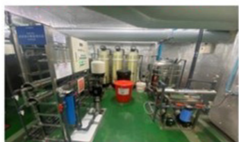
加護病房RO製程廢水回收 每小時廢水量約為1.5噸
