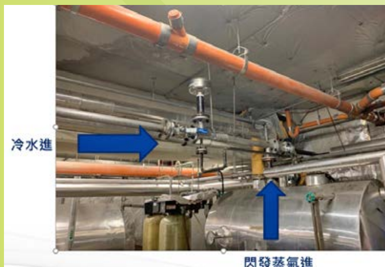
▲閃發蒸氣廢熱回收系統
