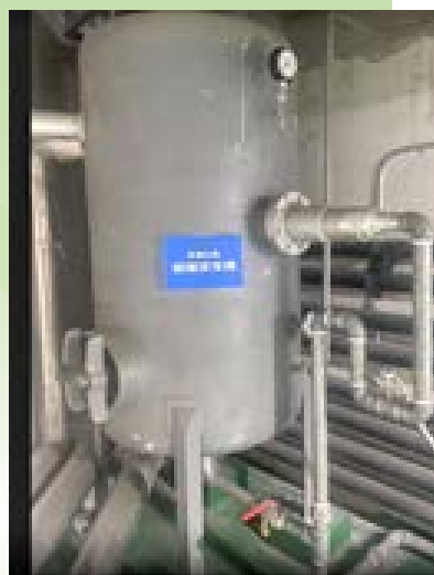
◀濃度控制器 ▼鍋爐排泄槽
